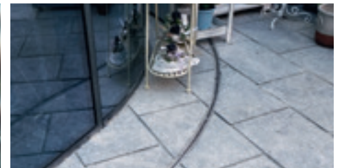
TE rigolă cu fantă pentru terasă – curbată
