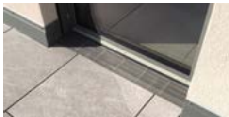
FA avec Grille à barreaux longitudinaux design
