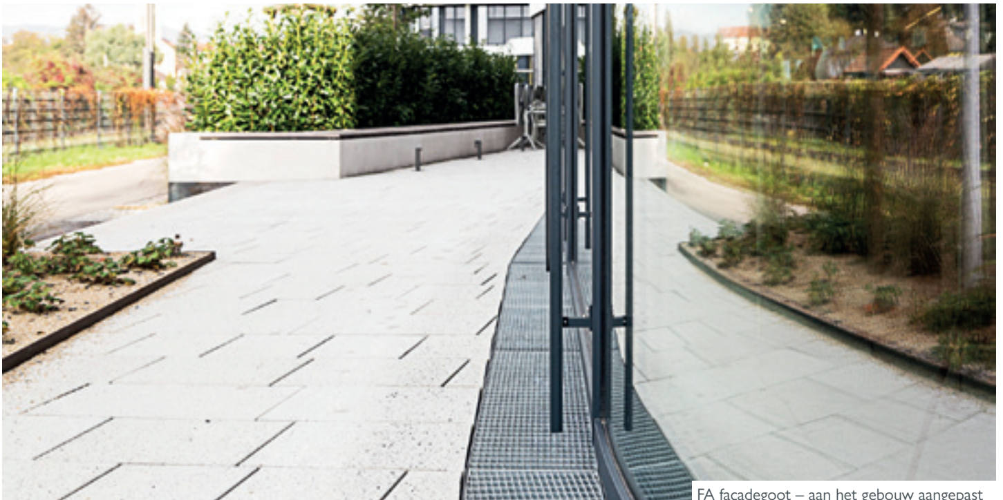
FA façadegoot – aan het gebouw aangepast
