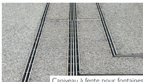
Caniveau à fente pour fontaines
