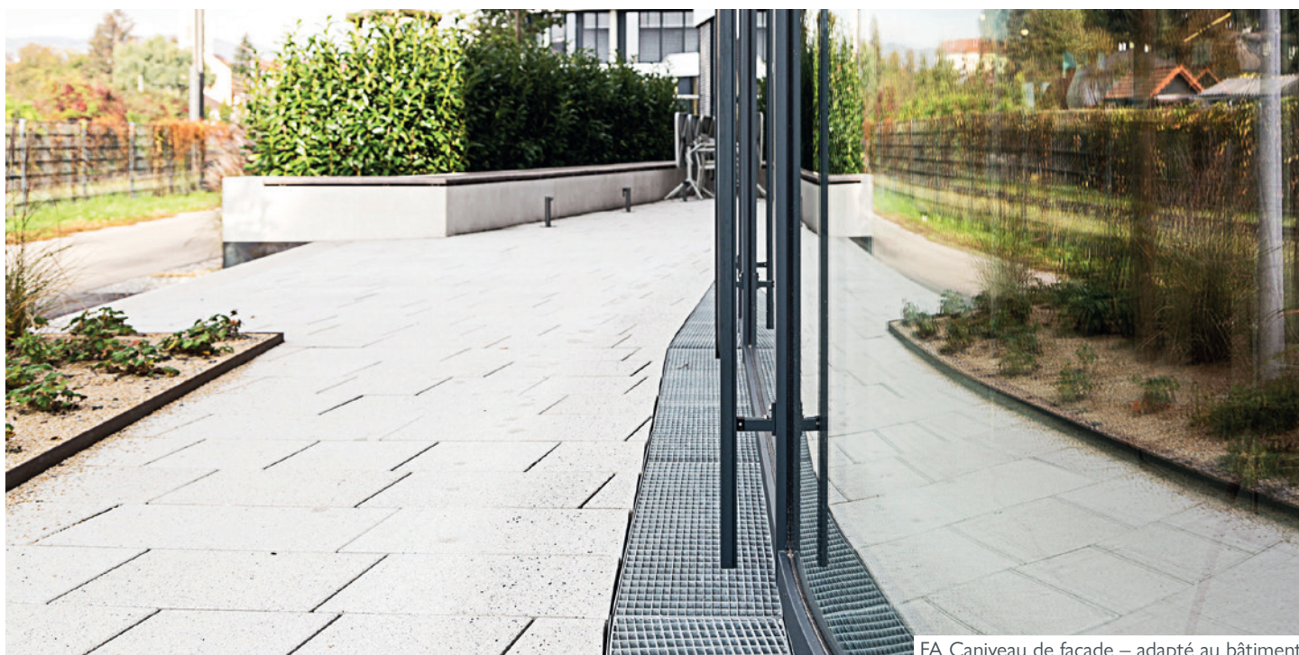
FA Caniveau de façade – adapté au bâtiment
