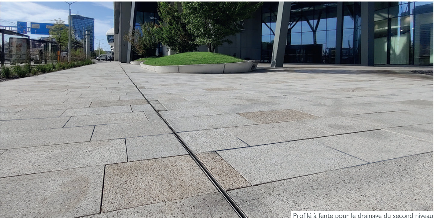
Profilé à fente pour le drainage du second niveau
