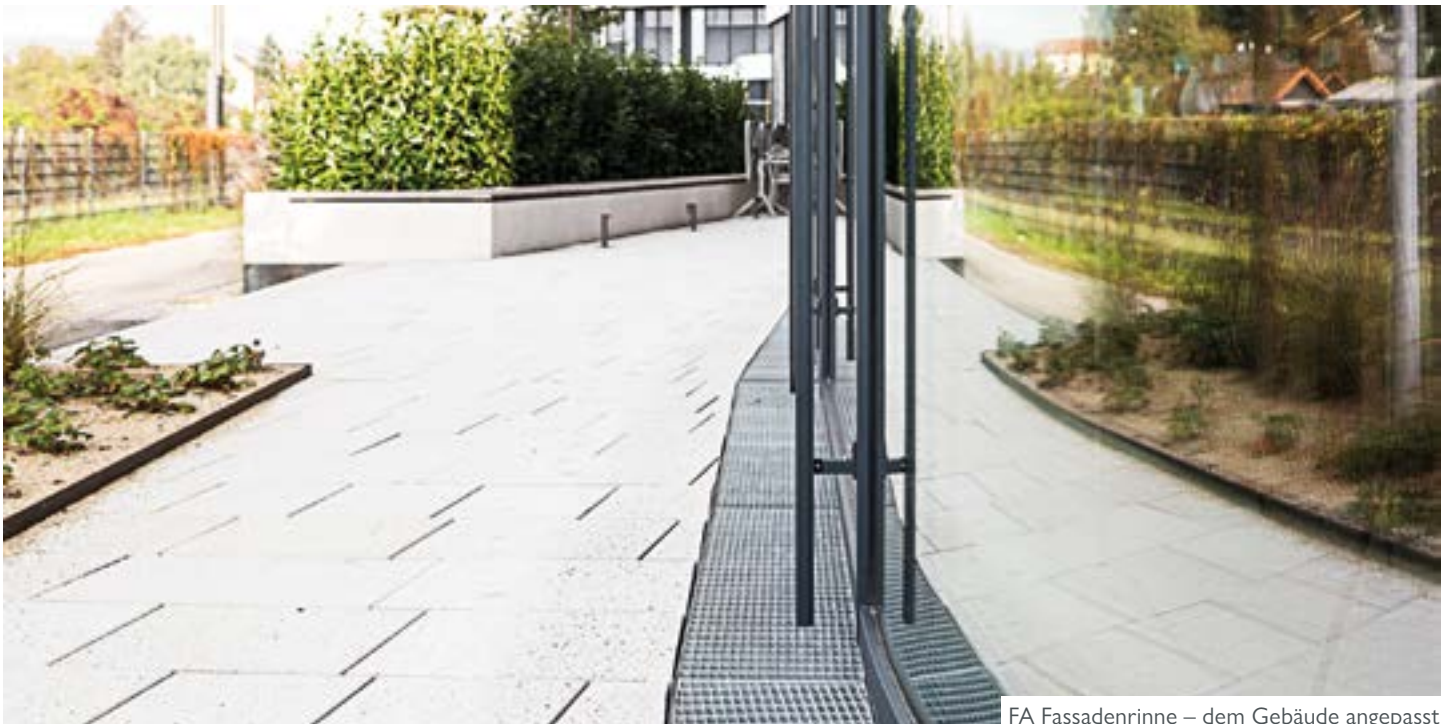
FA Fassadenrinne – dem Gebäude angepasst
