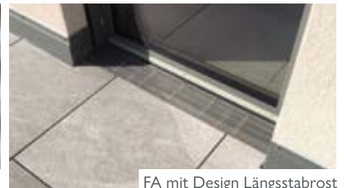
Schlitzaufsatz mit Drainageschlitze zur Entwässerung der zweiten Ebene
