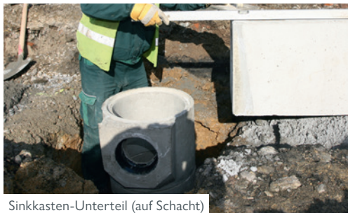
Sinkkasten-Unterteil (auf Schacht)
