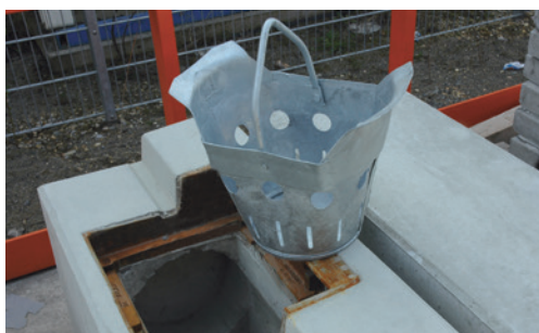
Sinkkasten fertig eingebaut
