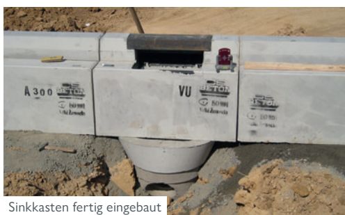
Sinkkasten fertig eingebaut
