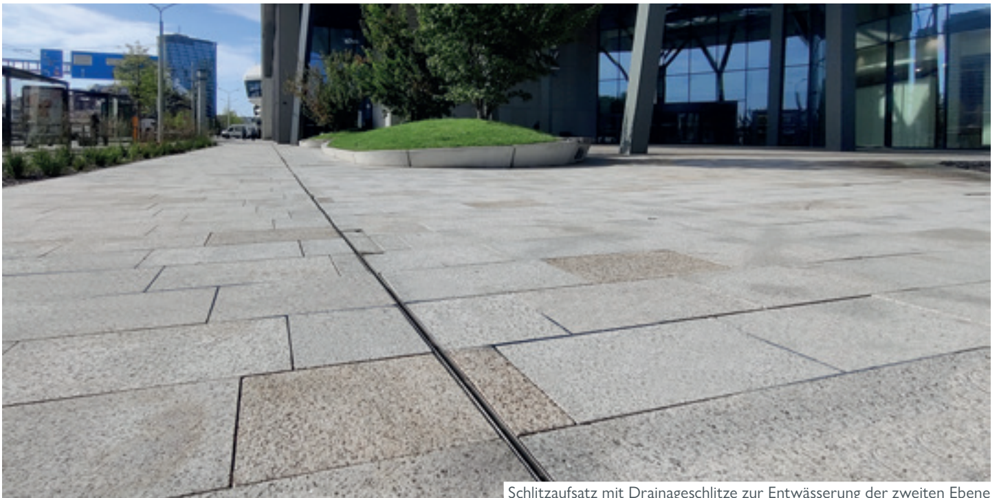
Schlitzaufsatz mit Drainageschlitz zur Entwässerung der zweiten Ebene
