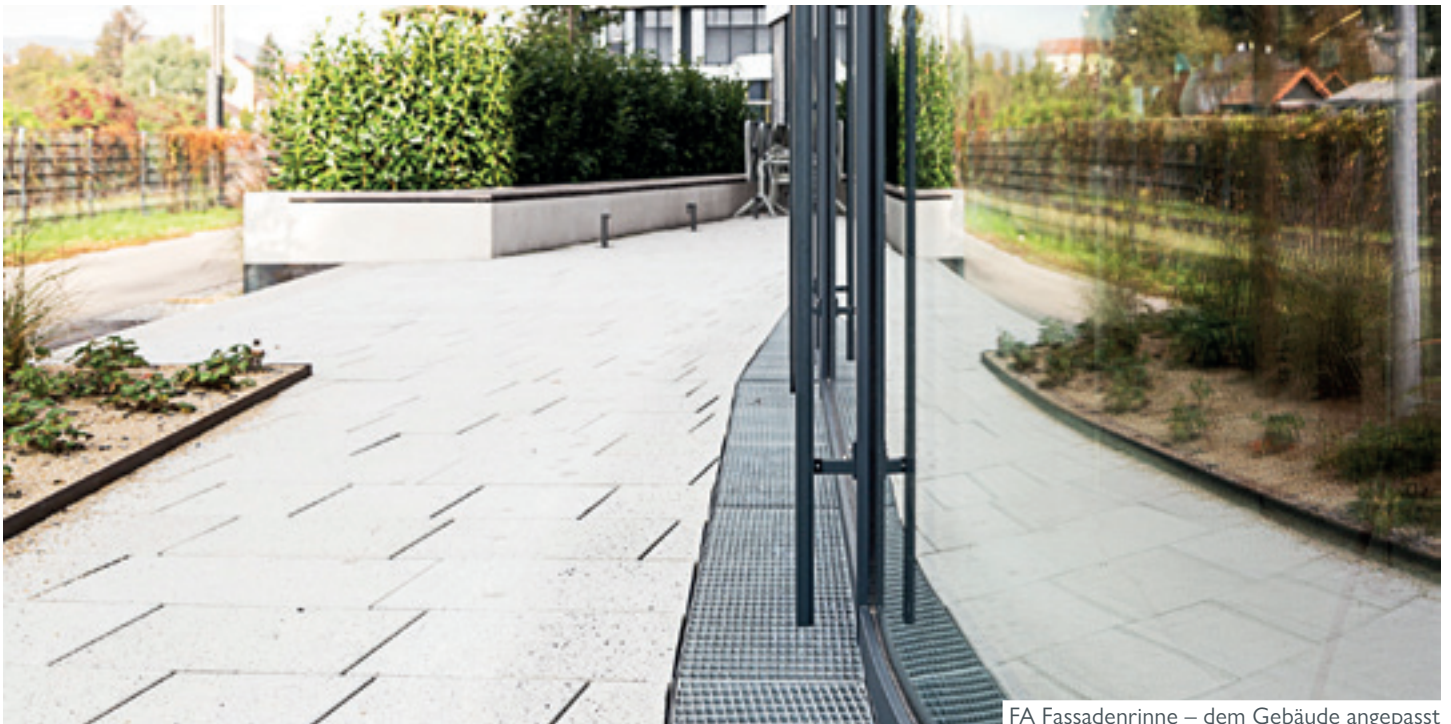
FA Fassadenrinne – dem Gebäude angepasst
