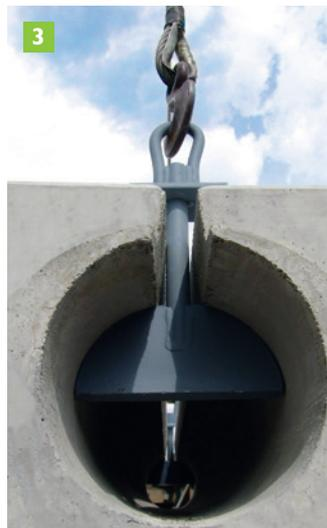
**3.** Zuerst wird der Unterteil des Versetzwerkzeuges im Rinnenschlitz versenkt - durch eine 90° Drehung wird dieser im Schlitz verdrehsicher eingerichtet. Nun kann das Hebegerät vom Kran oder Bagger beim Versetzwerkzeug eingehakt und die Rinne einfach und sicher versetzt werden.
