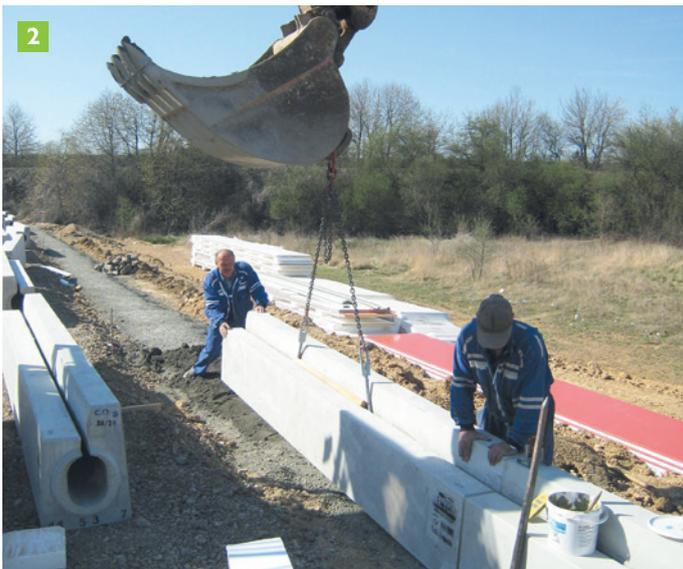
**KI. D 400 kN, Typ I - kein lastabtragendes Fundament erforderlich.** Die Verlegung erfolgt auf eine mechanisch verdichtete Tragschicht (=Frostschuttschicht) sowie einer Sauberkeits- bzw. Ausgleichsschicht aus Beton.
